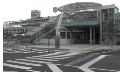
小山駅東口新駅前広場
