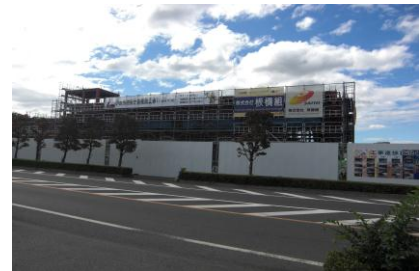
建設中の新消防庁舎
