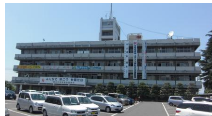
老朽化が進む『市役所本庁舎』
